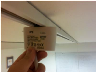
2. Stromabnehmer im Uhrzeigersinn<sup>1)</sup> um 90° drehen, bis die Sicherungsnase in das Gleis einklinkt
