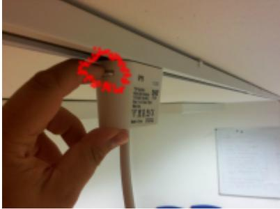
2. Stromabnehmer gegen den Uhrzeigersinn<sup>2)</sup> um 90° drehen, bis das Typenschild nach Süden (gelbe Wand) zeigt
